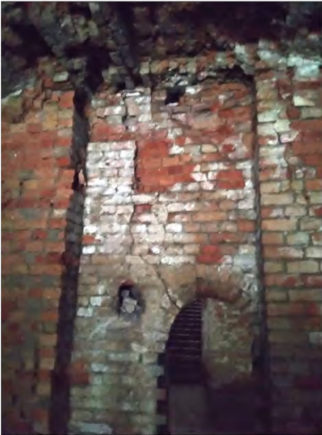
Фото 4. Вентиляційний отвір.
