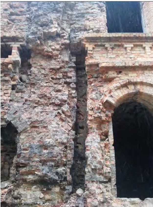
Фото 5. Зруйновані заглиблення для водозливних каналів.
