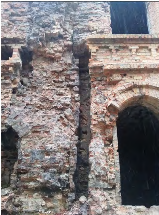
Фото 5. Зруйновані заглиблення для водозливних каналів.
